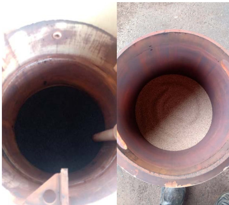
Fotos 01 e 02: Visualização dos trabalhos de limpeza da Caixa Separadora (CSAO) do Sistema de Remediação Ambiental e troca do carvão, em outubro de 2021.
