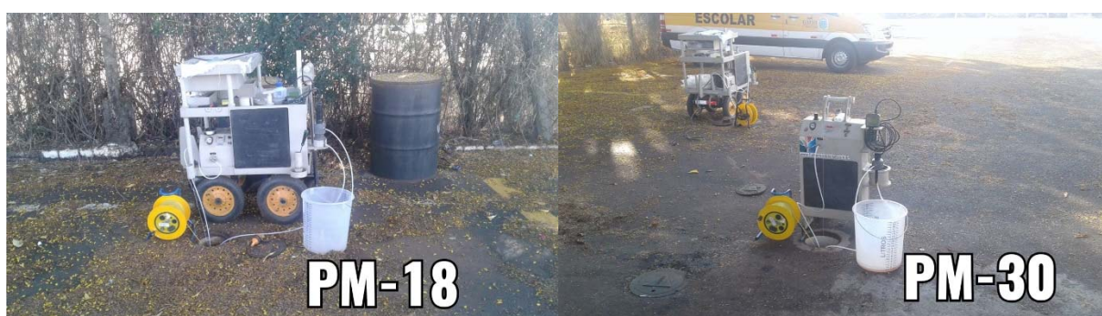
Fotos 05 e 06: Visualização dos trabalhos de amostragem em água subterrânea junto aos poços PM-18 e PM-30, em setembro de 2021.
