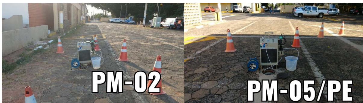
Fotos 01 e 02: Visualização dos trabalhos de amostragem em água subterrânea junto aos poços PM-02 e PM-05/PE, em abril de 2021.
