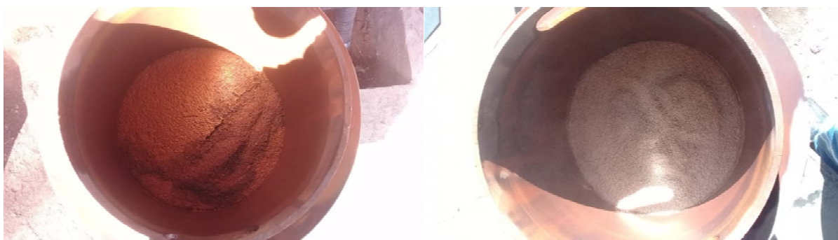
Fotos 07 e 08: Visualização dos trabalhos de limpeza do sistema, em junho de 2021.
